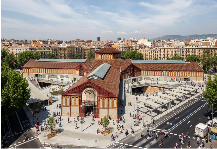
Figura 4: La remodelació del Mercat de Sant Antoni
