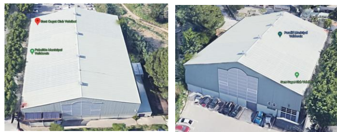
Figura 2: Coberta Pavelló Valldoreix. Font: Google Earth
