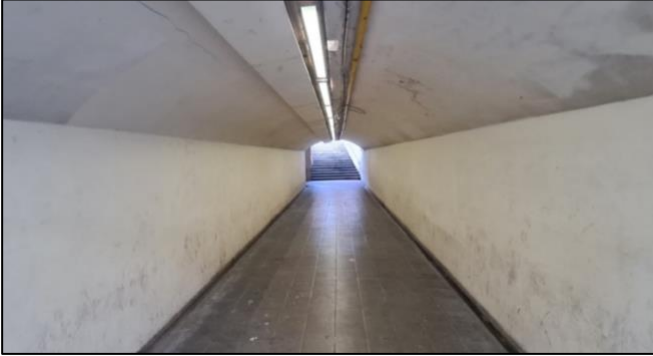
Imatge 1: Imatge del pas subterrani de l'estació.
