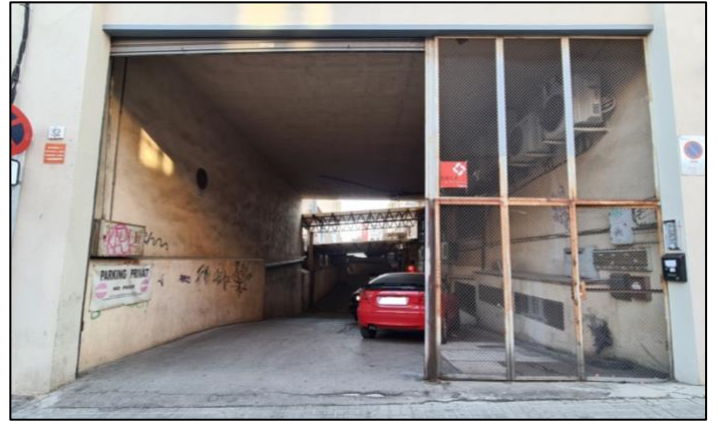
Imatge 13: Imatge de la zona d'estacionament carrer Iluro.
