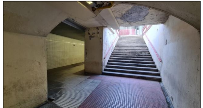
Imatge 2: Imatge del pas subterrani de l'estació.
