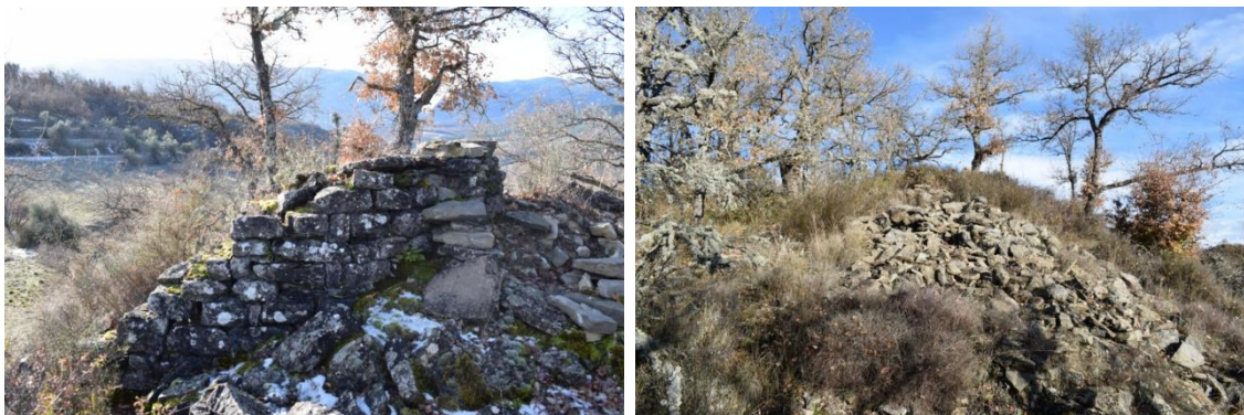
Imatge 4. Torre de Prullans: façana nord (esquerra) i enderroc de la façana sud (dreta) - Imatges de David Pociello i Bardina
