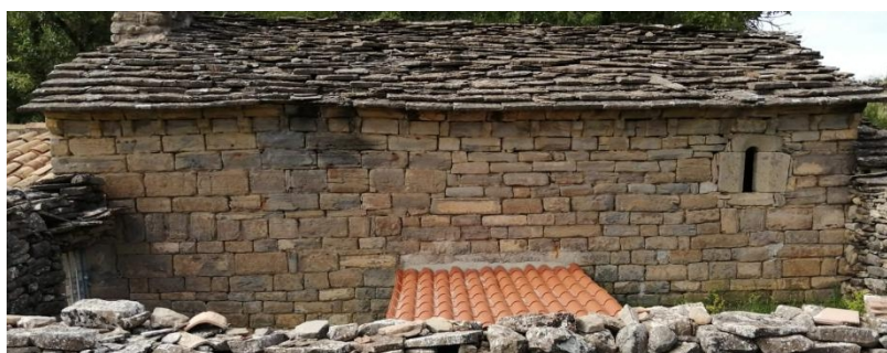
Imatge 5. Detall del mur sud, on s'aprecia la diferència entre els modes constructius i, a la dreta, la finestra no solidària. Imatge de Pol Pociello i Bardina
