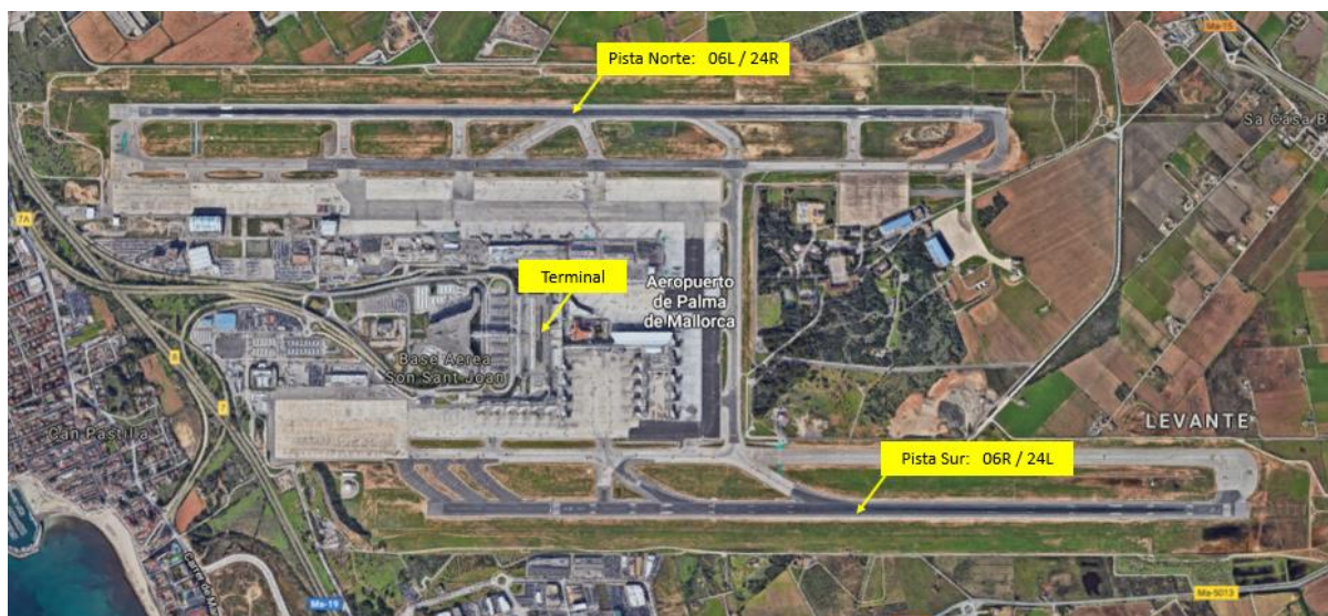
Figura 13. Vista aérea del aeropuerto de Palma de Mallorca.
