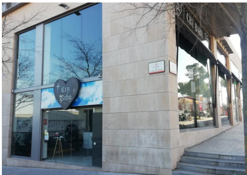
Ilustración 10. Vista exterior del local
