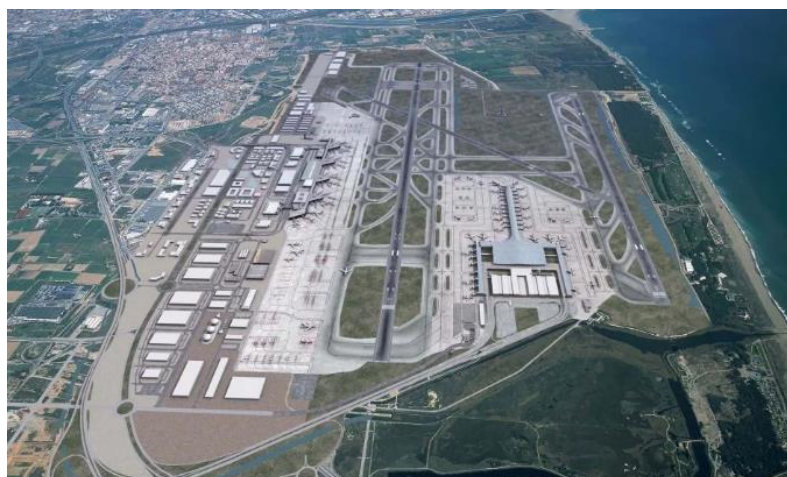
Fig. 15: Fotografia aèria amb totes les infraestructures de l'Aeroport de Barcelona – El Prat, 2020
