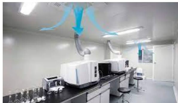
Figura 6.48: Ventilació bàsica requerida en un laboratori.
