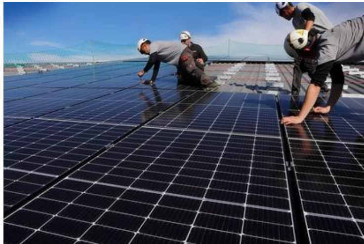
Figura 12.1: Instalación de placas solares
