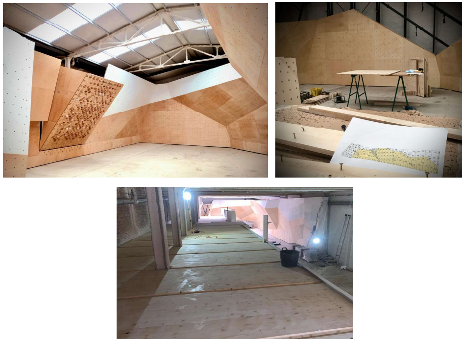
Imatges 48, 49 i 50. Estat de les obres nova seu social
