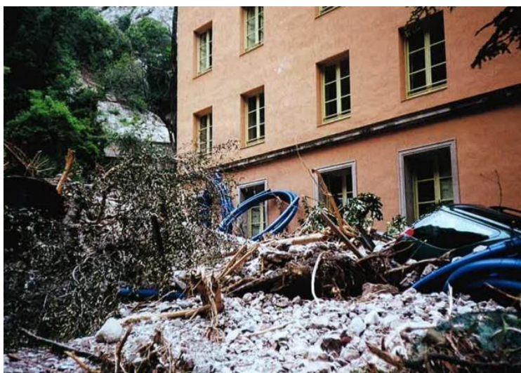
Imatge 21: Canal amb acumulació format a la Plaça de l'Abat Oliba. TotMontserrat
