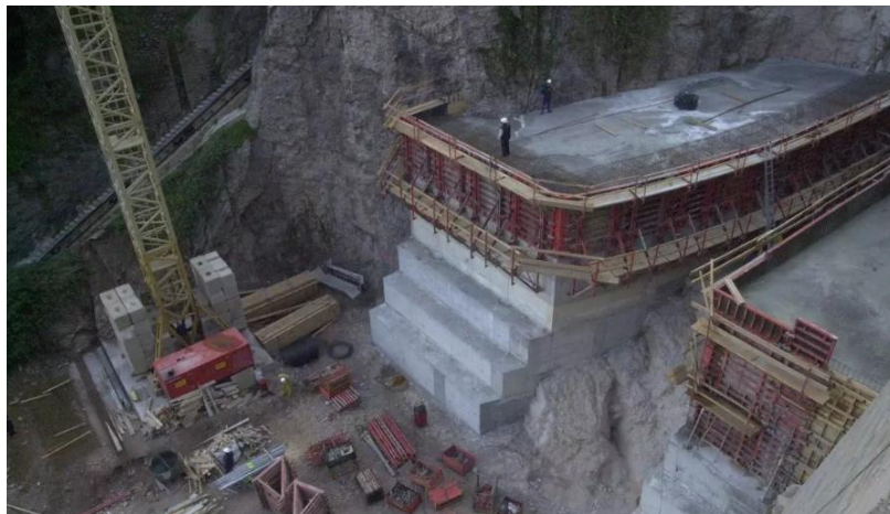
Imatge 20: Obres de canalització del Torrent de Santa Maria de Montserrat, l'any 2001. Regió7
