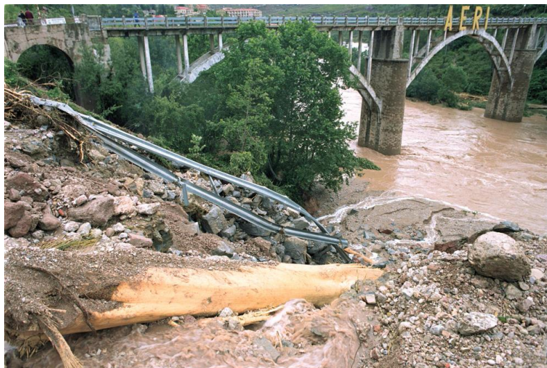
Imatge 9: La zona d'aparcament també va quedar destrossada. TotMontserrat
