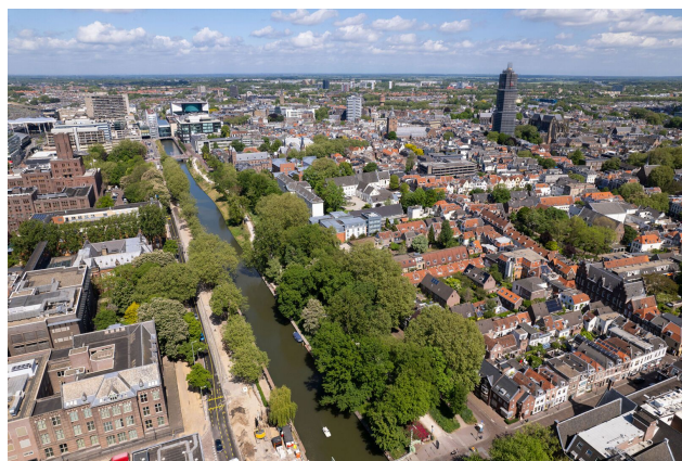
Fig. 3: Vista aèria del canal restaurat de Catharijnesingel, Utrecht. Font: ARQA
