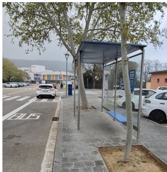
Fig. 5: És la parada 17 i compleix amb totes les variables d'infraestructura i accessibilitat, excepte la senyalització per a persones amb discapacitat visual.
