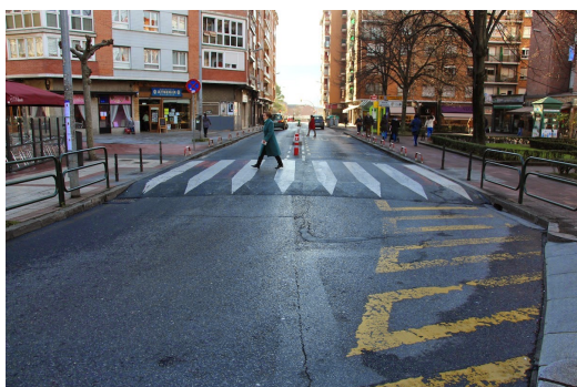
Figura 16: Pas de vianants elevat
