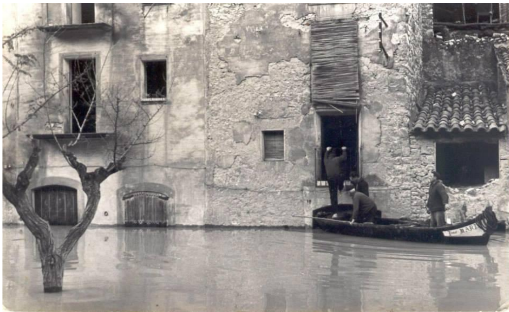
Il·lustració 8: Habitants de Faió durant la inundació (Juan Ribera Roca, 1967).
