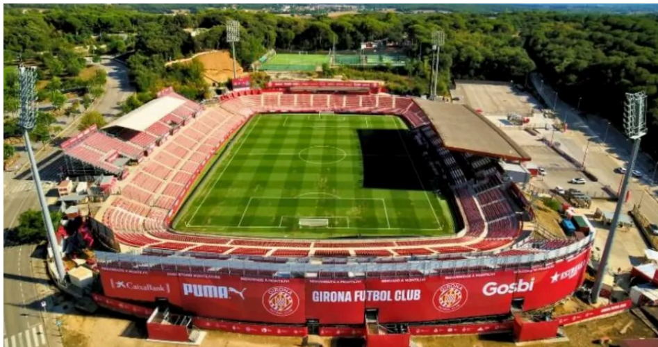
Imatge 11. Estadi Montilivi actual amb les grades retràctils. Capacitat 14.624
