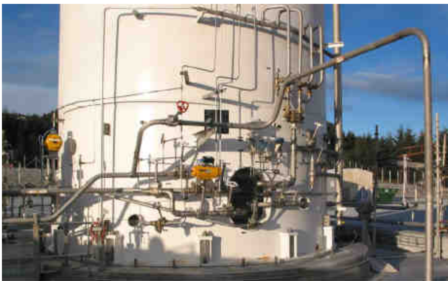
Figura 10.2 Sistema de control de pressió i instrumentació.
