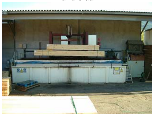
Figura 10. Instal·lació de tractament fundicida.
