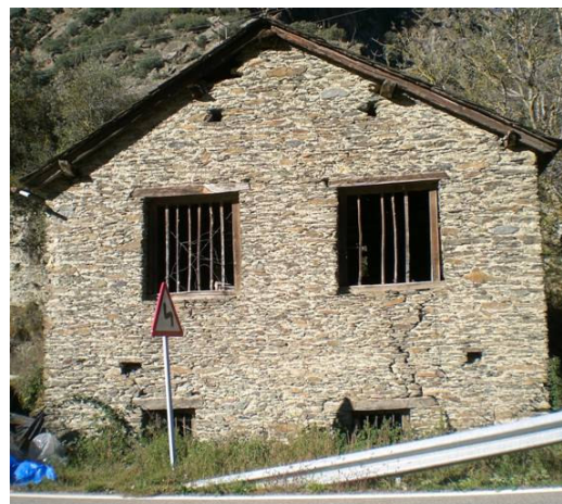
Imatge 2: Paret sud de la borda. Vista de les obertures del paller i l'estable.
