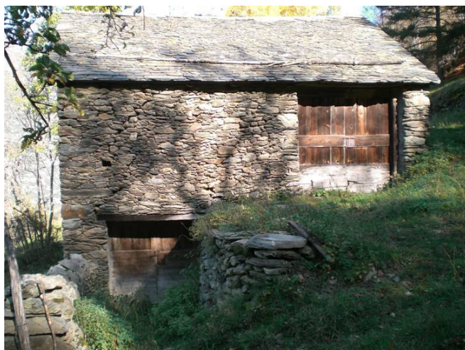
Imatge 1: Paret sud-oest de la borda. Entrades al paller i l'estable.
