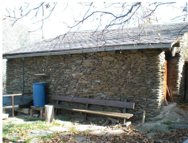
Imatge 2: Paret oest de la borda. Vista de l'entrada principal a l'habitatge.
