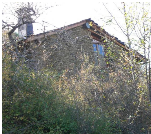
Imatge 1: Paret nord de la borda. Gaial convertit en finestra.
