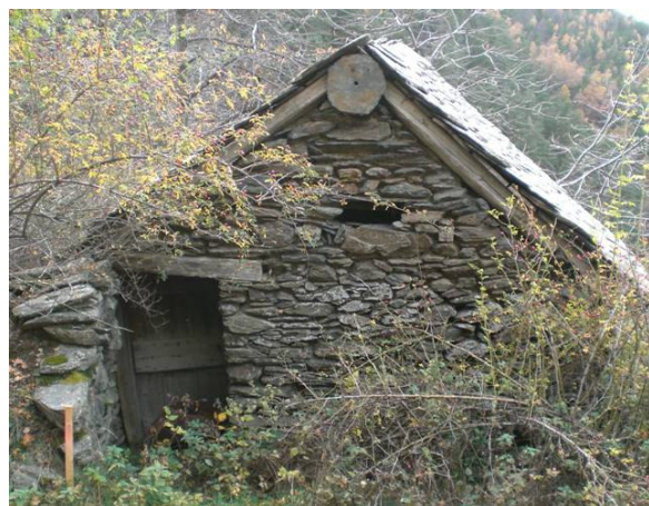
Imatge 3: Paret est de la borda. Entrada al paller
