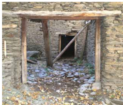
Imatge 3: Paret nord-oest. Entrada al corral batedor i a l'estable
