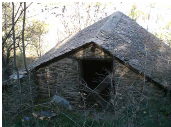
Imatge 1: Paret sud-est de la borda. Entrada al paller
