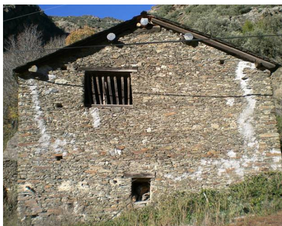
Imatge 1: Paret sud de la borda. Vista de les obertures del paller i l'estable.
