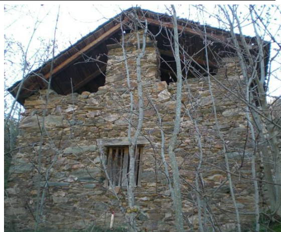
Imatge 2: Paret nord-oest de la borda. Vista dels gaials i l'obertura de l'estable.
