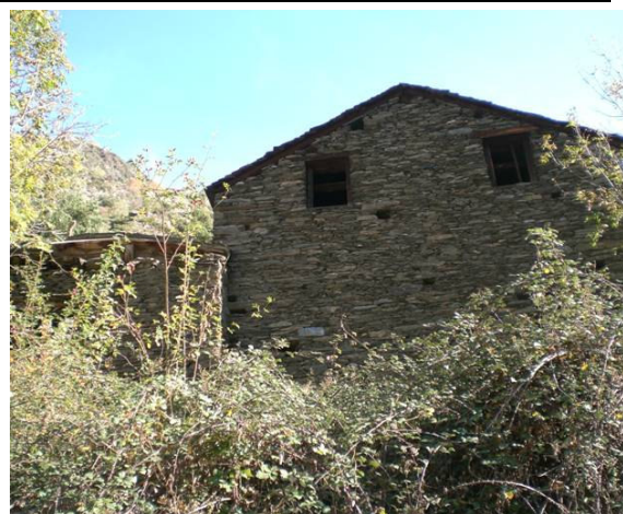
Imatge 2: Paret sud-oest de la borda. Vista dels gaials
