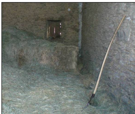
Imatge 3: Detall de les trapes del paller per on es tira l'herba a les menjadores.
