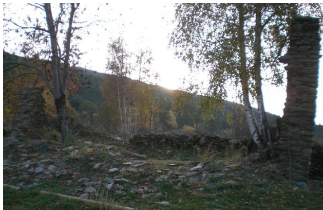
Imatge 6: Estructura enrunada de la Borda 3
