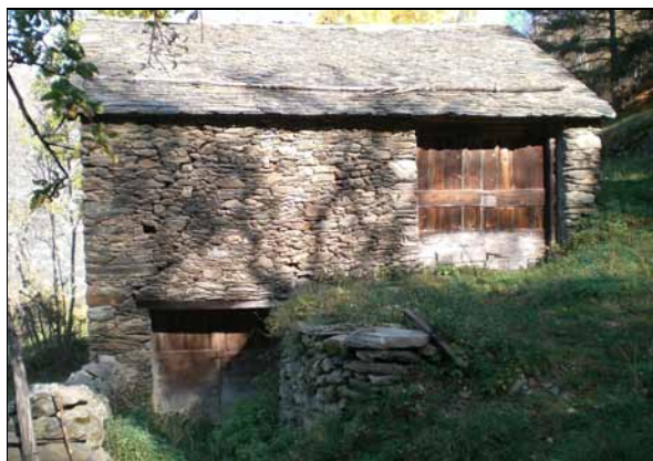
Imatge 5: Detall dels accessos diferenciat al paller i l'estable de la borda.
