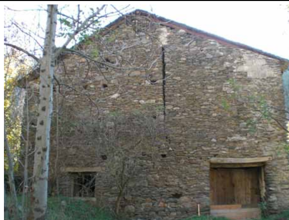
Imatge 2: Paret nord-oest de la borda. Entrada a l'estable i obertura. Vista de la restauració feta en la façana.
