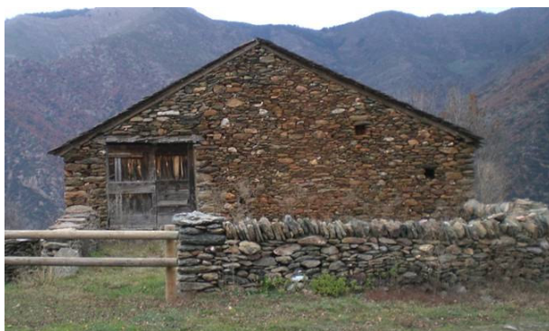
Imatge 3: Paret nord de la Borda 1 . Entrada al paller i corral exterior de pedra
