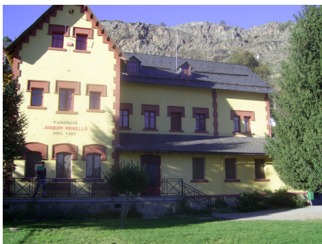
Figura 14. Edifici del Camp d'Aprenentatge de les Valls d'Àneu Font. Elaboració pròpia.
