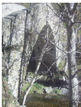
Figura 38. Imatge del pont medieval de Cassibrós. Font: Elaboració pròpia.
