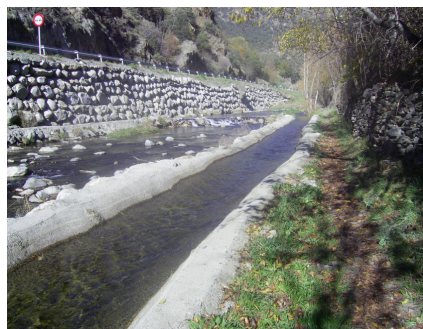
Figura 41. Imatge de les actuacions antròpiques sobre el curs fluvial. Font: Elaboració pròpia.
