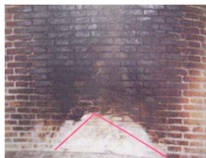
Figuras 4.2 y 4.3 – Escenarios de incendios que muestran la ubicación de llama. Nótese la forma de “V” invertida.
