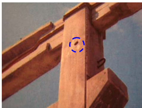
Fotografía 5.3 – Detalle del lugar de extracción de una de las probetas para su ensayo (en azul)
