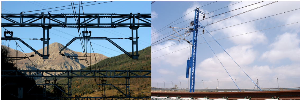
Ilustración 1 – Arcos de alimentación, postes de sujeción y catenarias
