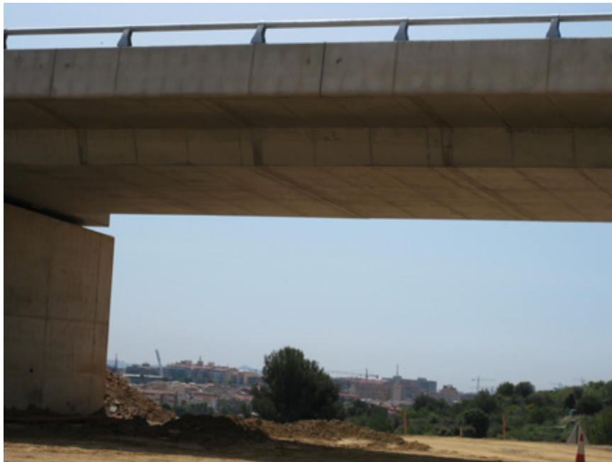
A sota un viaducte del quart cinturó, al fons la ciutat.
