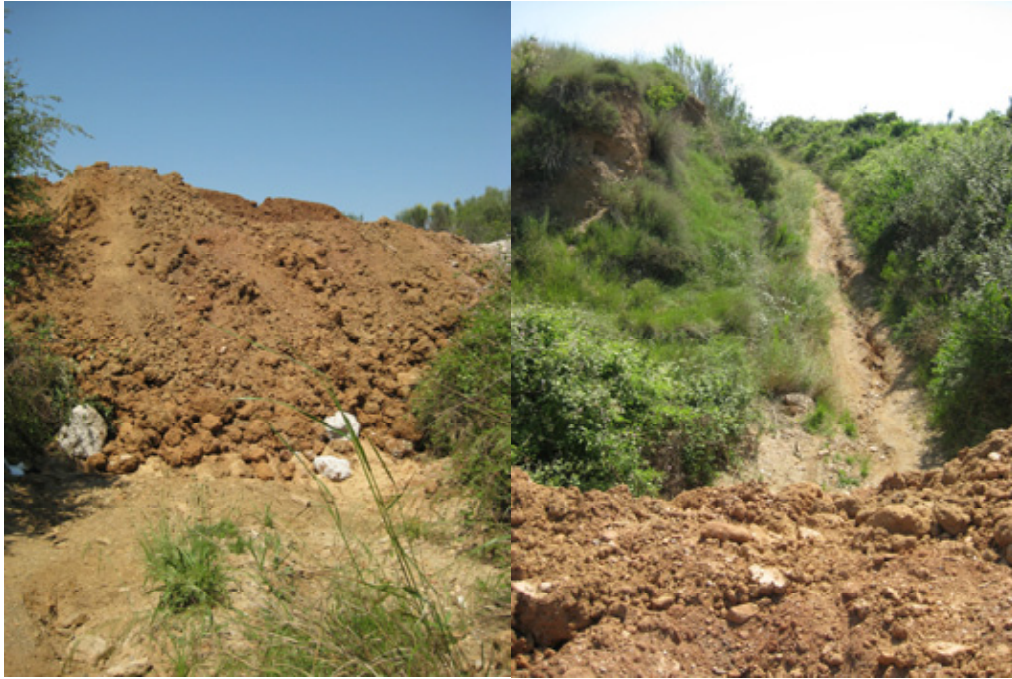
Impactes evitables de les obres del quart cinturó: tapant un camí inclòs en la proposta d'itineraris de la diagnosi de la proposta (amb projecte executiu encarregat).
