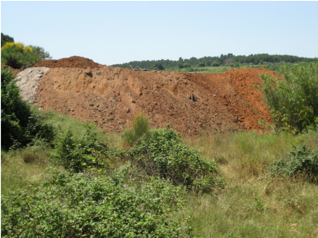
Impactes evitables de les obres del quart cinturó: tapant un torrent.
