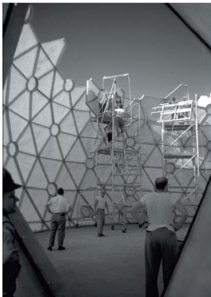
Construcció i divisió d'una esfera geodèsica
