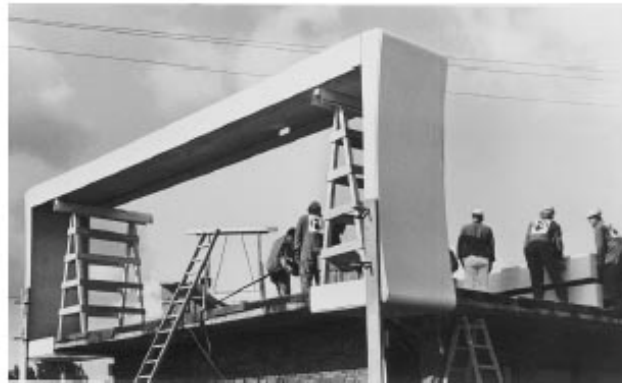
Construcció de les vivendes fg2000
