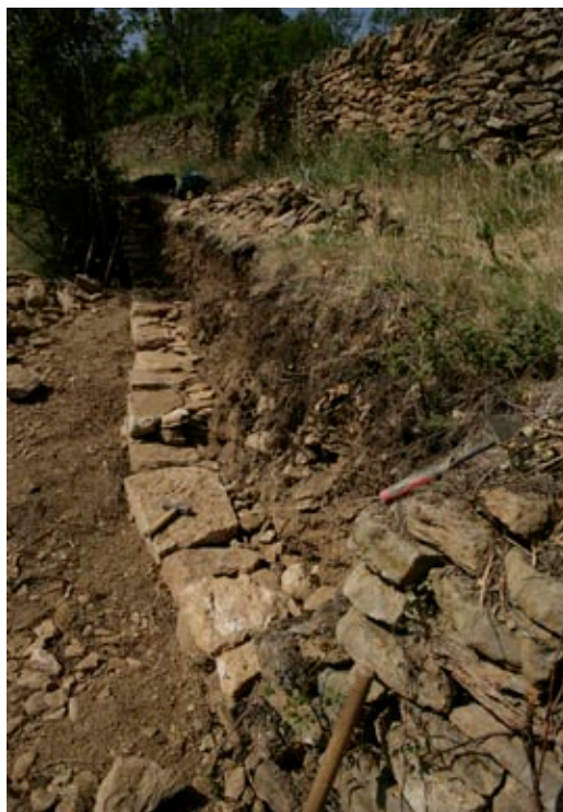
Primeres filades de pedra del marge
