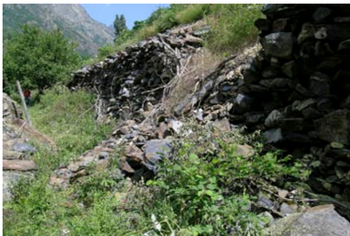
Esbalçader en camí de ferradura
