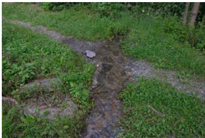
Drenatge simple en un curs constant d'aigua
