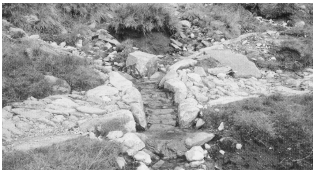
Drenatge en forma de canaleta
