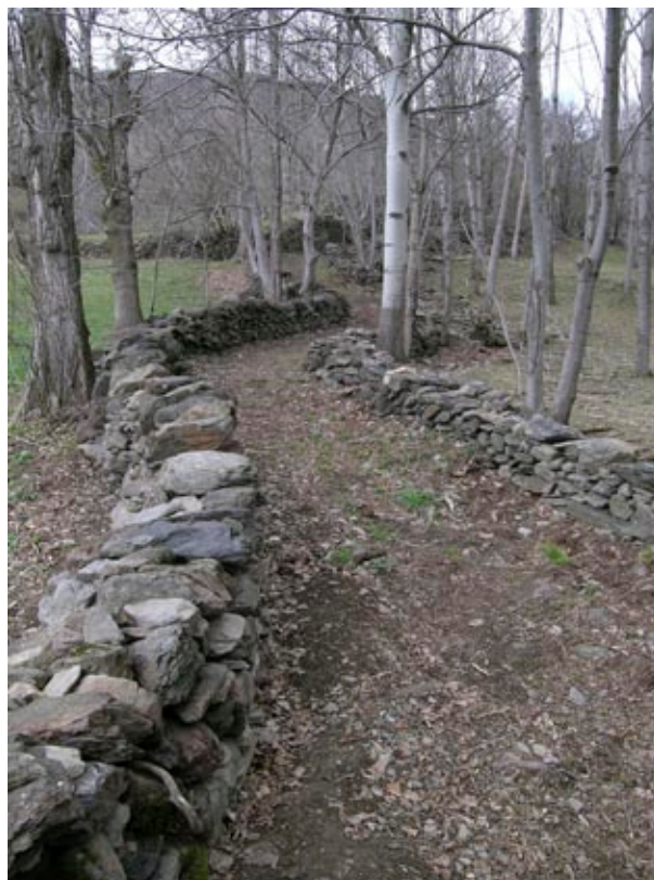
Camí anivellat, despedregat i rasclejat ja amb els murets reconstruïts.
