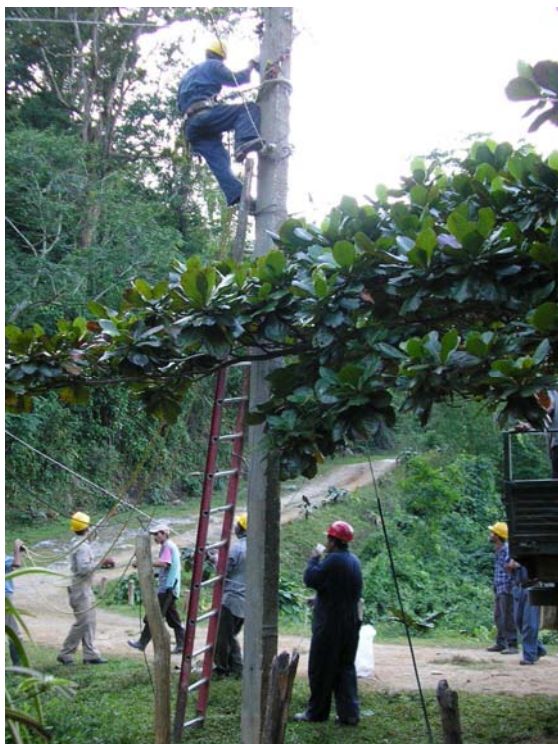
Imágenes 2.3 y 2.4: Reparación de las líneas de transmisión y distribución en zonas rurales (Manantiales, Escambrai. Villa Clara). y en la derecha, líneas de transmisión de alto voltaje. Elaboración propia
