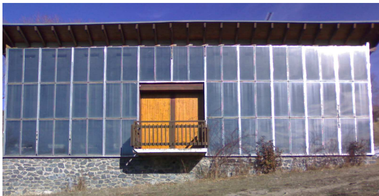
Figura 1.9: Imatge d'un Mur Trombe instal·lat a la Cerdanya.
