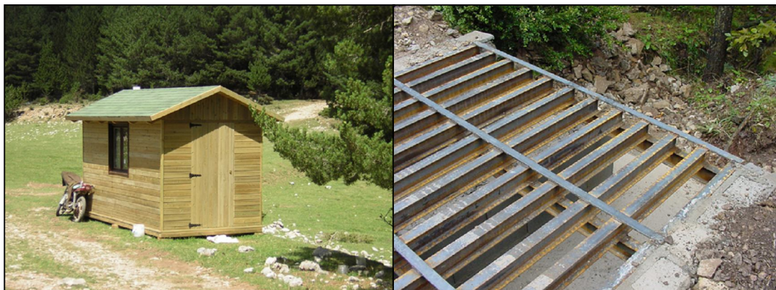
Imatges 4 i 5: Barraca de pastor (a l'esquerra) i pas canadenc (a la dreta) instal·lats al Parc Natural del Cadí-Moixeró
