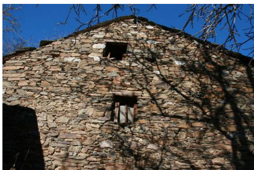
Imatge 7.13.2: Vista de la paret sud de la borda
