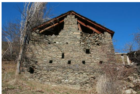
Imatge 7.13.5: Paret sud de la borda. Detall dels gaials i els forats
