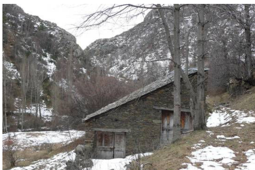
Imatge 7.7.1: Paret nord de la borda. Vista de les portes de l'estable i del paller. S'observa la teulada d'una sola aigua
