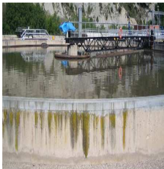
Sedimentación primaria por gravedad.
