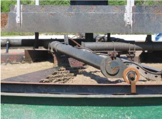
Espesamiento de lodos por flotación
