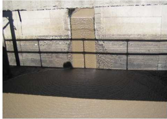
Lodos espesados almacenados antes de la digestión
