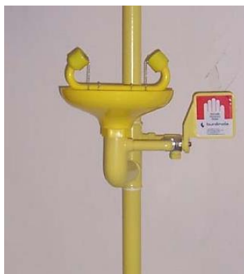
Figura 5.10.1.2.3. Fotografía de equipo lavaojos de seguridad.
