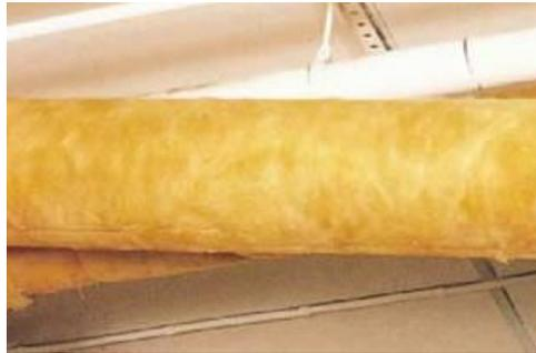
**Figura 4. 2:** Aislamiento de tuberías tipo coquilla Roclairne.
