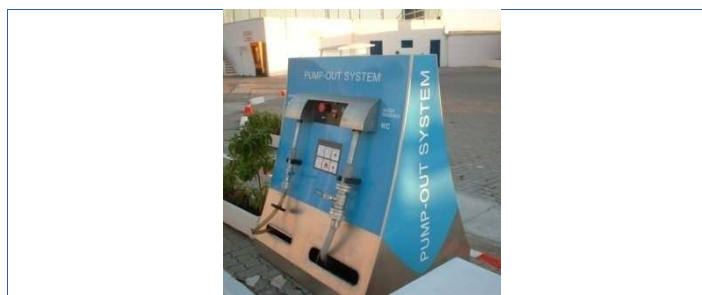
Figura 8: Fotografia de l'aspirador d'autoservei d'aigües residuals i de sentina del Port Esportiu d'Aiguadolç. Font: Port d'Aiguadolç-Sitges S.A.
