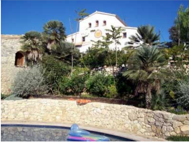
Figura 17: Exterior ETR. Font: Cal Simó
