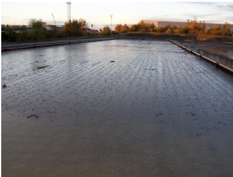
Fotografia 10: Aiguamoll construït d'aeració forçada; Mayfield Farm, Heathrow Airport. Font: ARM.
