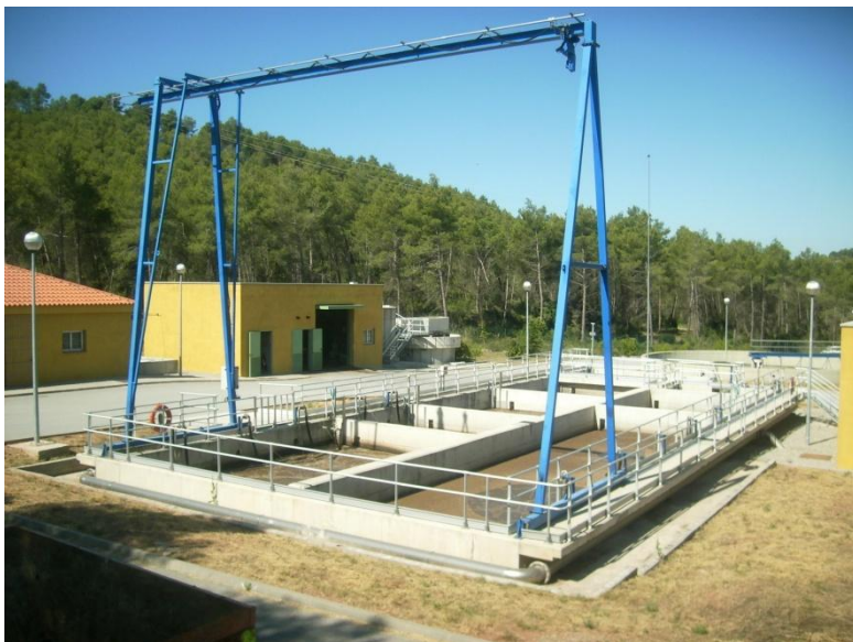
Fotografia 1: Vista parcial de la planta. Font: pròpia.
