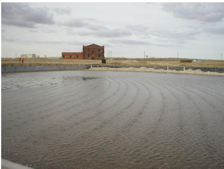
Fotografia 11: Aiguamoll construït d'aeració forçada; BP Casper Refinery (America). Font: ARM.
