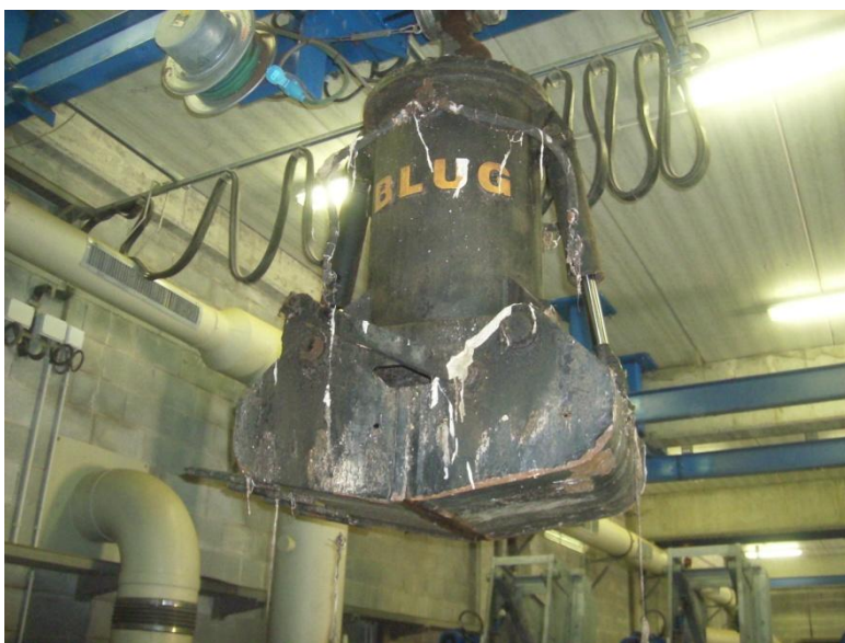
Fotografia 2: Cullera bivalva del pretractament. Font: pròpia.
