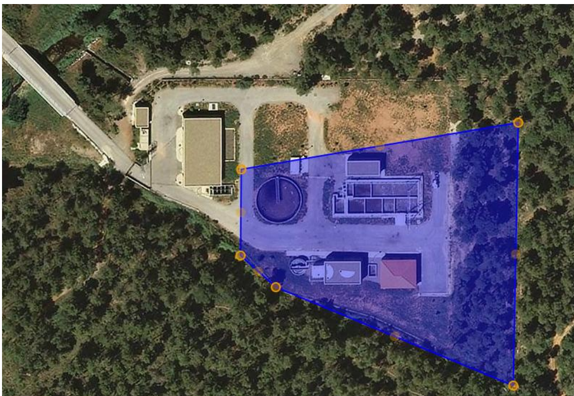
Figura 43: Ortofotomapa de la depuradora de Begues, superfície de 6.000m 2 pels aiguamolls construïts, 1:2.500. Font: pròpia en base a www.icc.cat .
