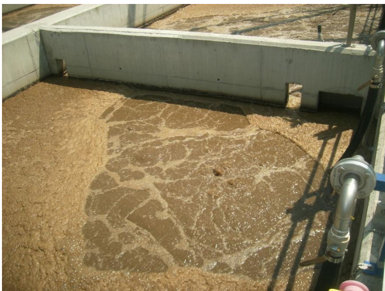
Fotografia 5: Vista del compartiment aeròbic del reactor biològic. Font: pròpia.
