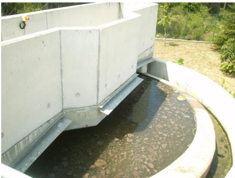
Fotografia 7: Espessidor de fangs. Font: pròpia.
