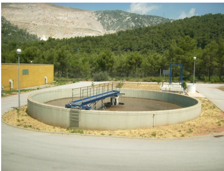
Fotografia 6: Decantador secundari. Font: pròpia.
