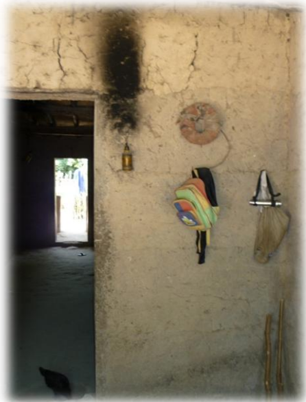
Fig. 2.6: Efectes dels fums del querosè sobre les parets. Font: d'autor.
