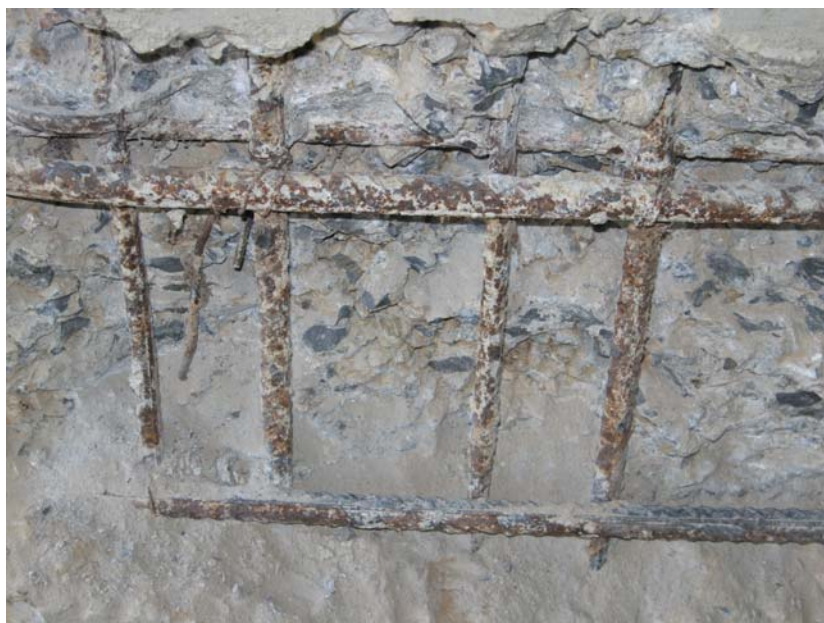
Figura 18. Muestra 4 Aspecto de la armadura. Zona de armadura al aire.
