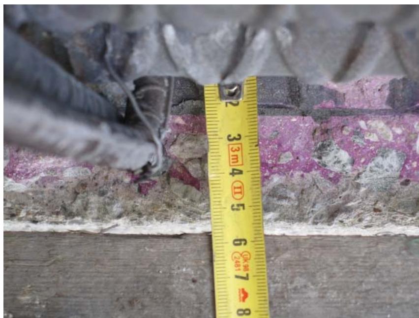
Figura 29. Recubrimiento de las armaduras y frente de carbonatación. No hay corrosión de armaduras.
