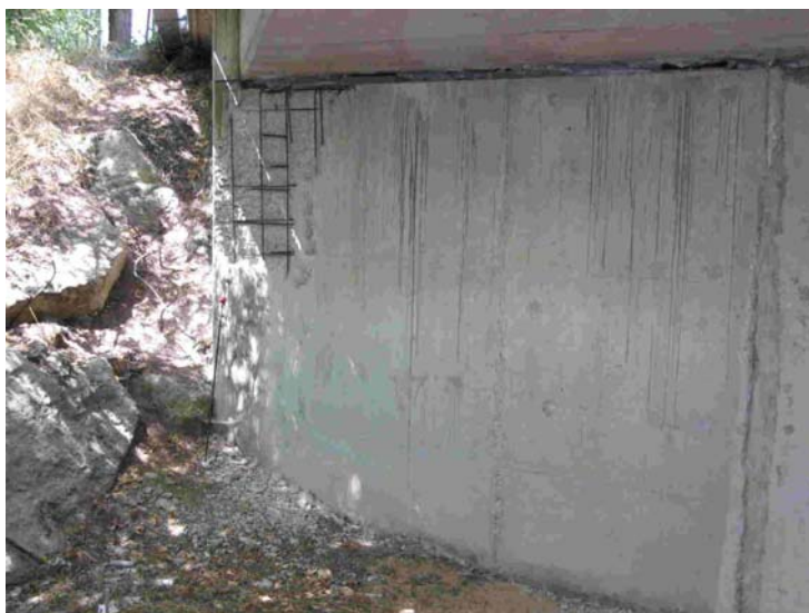
Figura 11. Corrosión de armaduras en la zona de estribo ampliado
