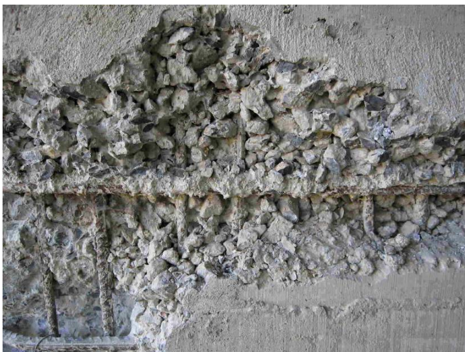
Figura 17. Muestra 4 Aspecto del hormigón. Segregación del hormigón con armadura al aire y oxidada.
