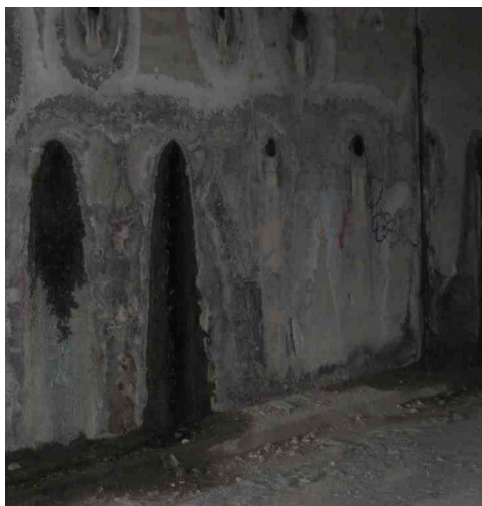
Figura 24. Aspecto del hastial de la obra de fábrica. Paso de agua por latiguillos y eflorescencias con marcas de humedad.
