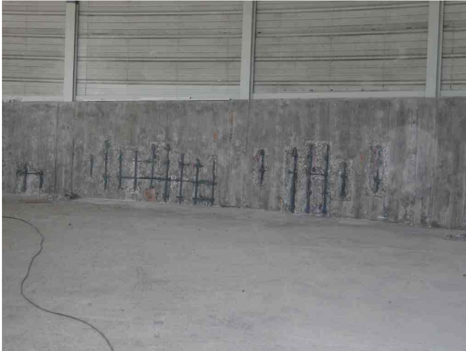
Figura 47. Aspecto del interior del silo. Saneo y pasivado de las armaduras.
