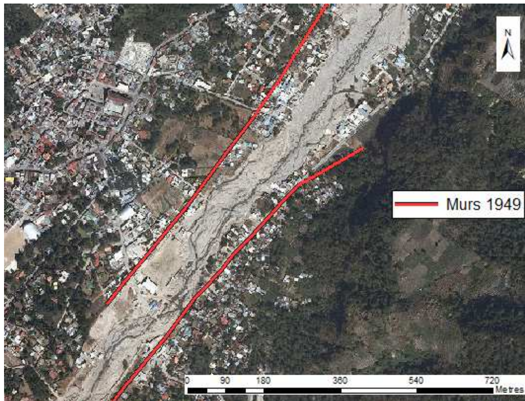
Figura 3.23.a Construcció de vivendes dins de la llera delimitada pels murs de l'any 1949, al municipi de Panajachel. Font: Elaboració pròpia.
