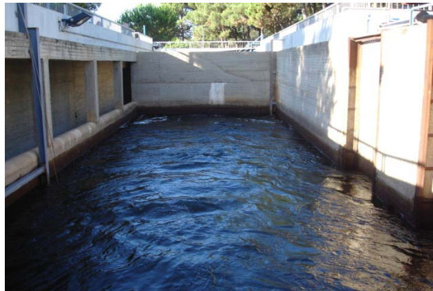
Imatge7: Fotografia de l'obra d'arribada de l'ETAP Ter. Font: ATLL
