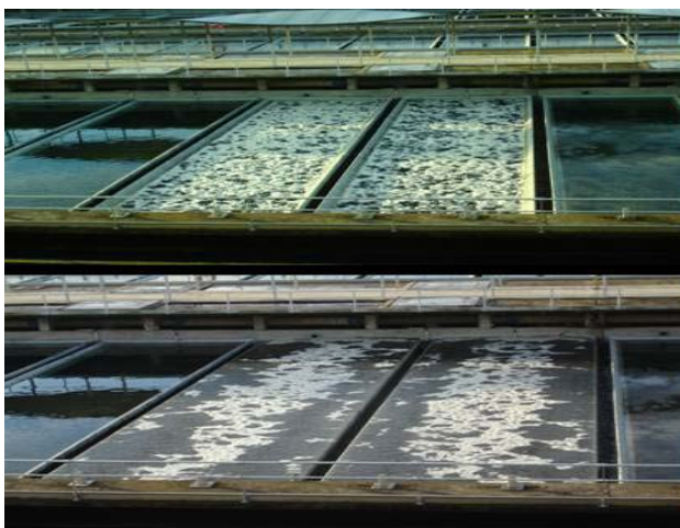
Imatge 9: Fotografia dels filtres de carbó de l'ETAP Ter. Font: ATLL
