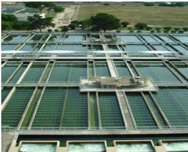
Imatge 8: Fotografia dels decantadors de l'ETAP Ter. Font: ATLL
