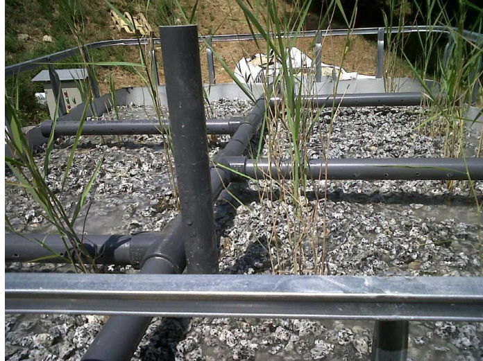
Figura 6. Entrada aigua residual a l'AFSSV.
