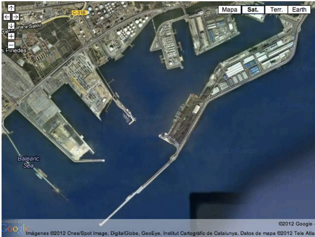
Figura 2: Vista aérea del puerto de Tarragona
