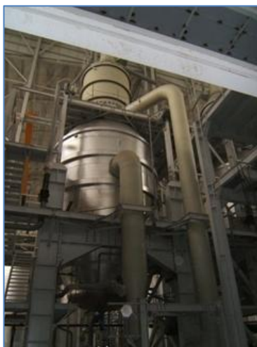
Figura 11.5.2. Fotografía de una cristalizador Oslo por evaporación
