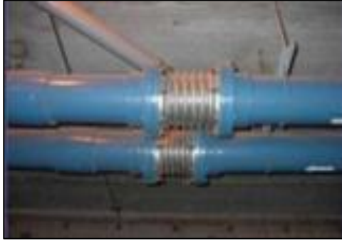
Figura 4.3.2.9 Junta d'expansió instal·lada en una canonada.
