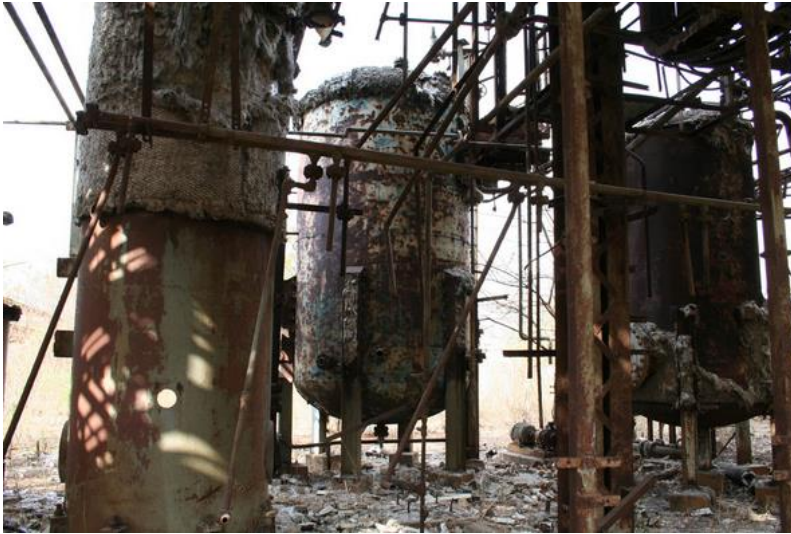
Figura 5.2.1 Planta química situada a Bhopal.
