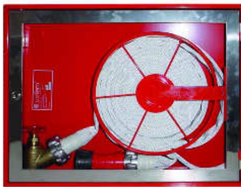
Figura 5.8.4.4. Boca d'incendi equipada.
