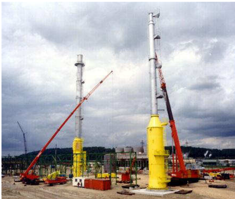
Figura 5.13.4-1. Antorcha autosoportada.
