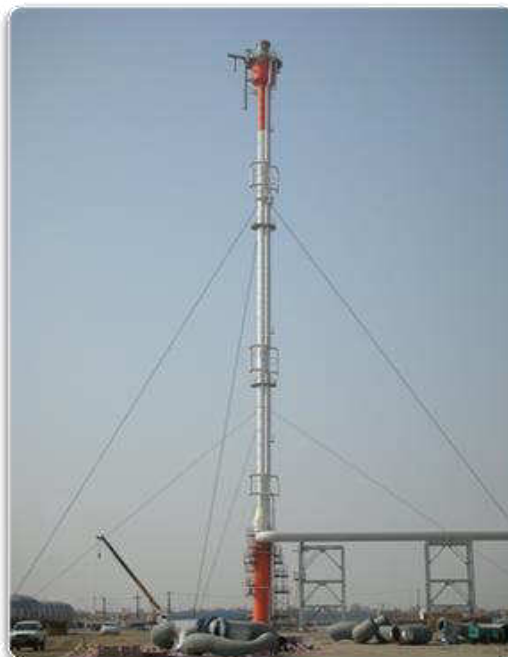
Figura 5.13.4-3. Antorcha tipo Guywired.
