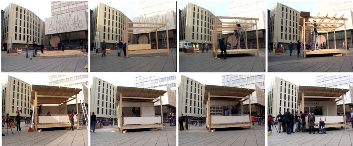
23/11/2002. Montaje de la caseta desmontable de Josep Lluís Sert. Josep Llinás y F/451 Arquitectura.
