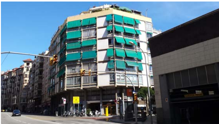
El edificio de Balmes 346, esquina Padua, última residencia de Denys Choffat
