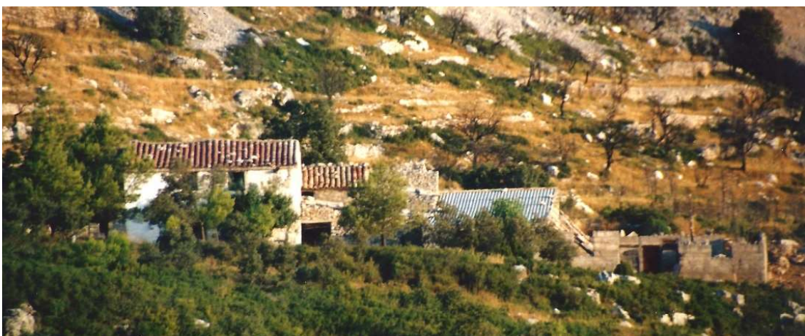
Figura 28. Mas de Basilio, amb les últimes parts de la dreta amb teulada d'uralita i parets de blocs de formigó. Font: arxiu propi. Fotografia d'E. Beltran.
