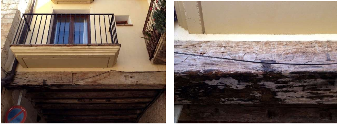
Figura 23. Cabiró transportat del Palau dels Comptes de Pestagua (construït, com indica, al 1691) fins el Perxe Fosc, a la Plaça Vella. Font: arxiu propi. Fotografia de M. Beltran.
